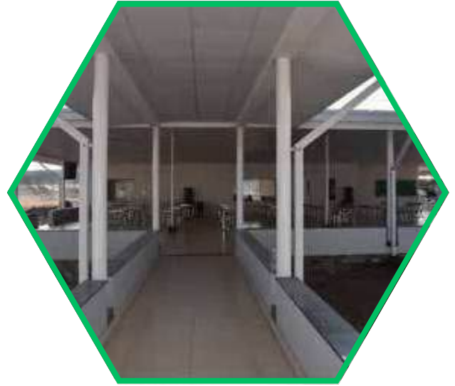
Thi công công trình MDF
