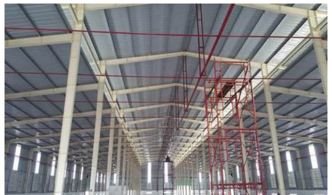
Toàn cảnh khu nhà máy OVERALL VIEW OF THE FACTORY COMPLEX
