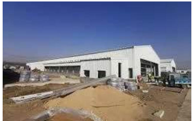
Thi công kết cấu thép STEEL STRUCTURE CONSTRUCTION
