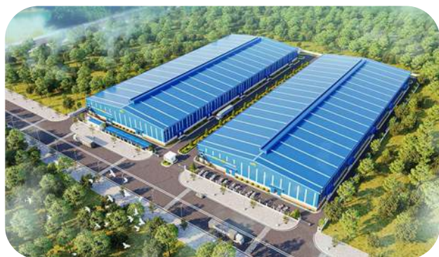
Sản Xuất Cọc Tiếp Địa GROUND ROD MANUFACTURING
