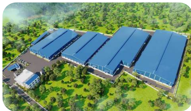
Nhà máy tôn - thép SATA SATA STEEL & ROOFING SHEET FACTORY
