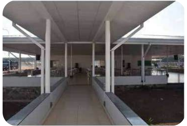
Thi công công trình MDF MDF CONSTRUCTION & INSTALLATION
