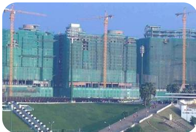
Công trường nhà cao tầng HIGH-RISE BUILDING CONSTRUCTION SITE
