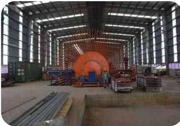
Nhà máy ván ban đêm NIGHT-TIME OPERATIONS & CONSTRUCTION
